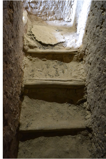
Fig. 17: Vue interne de la tour-minaret, mode constructif des marches et des contremarches
