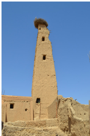
Fig. 14: Vue sur la tour-minaret, façade est (© S. Kafas, M. Belatik)
