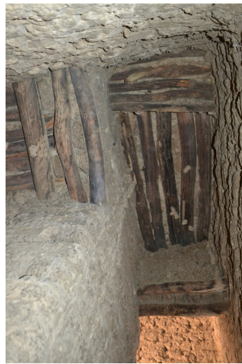
Fig. 19: Vue de l'intérieur de la tour-minaret, détail sur l'assemblage des poutres de bois.
