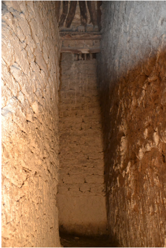
Fig. 16: Vue interne de la tour-minaret, détail de la maçonnerie en brique crue
