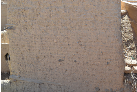
Fig. 22: Maçonnerie de brique crue (façade externe du minaret)
