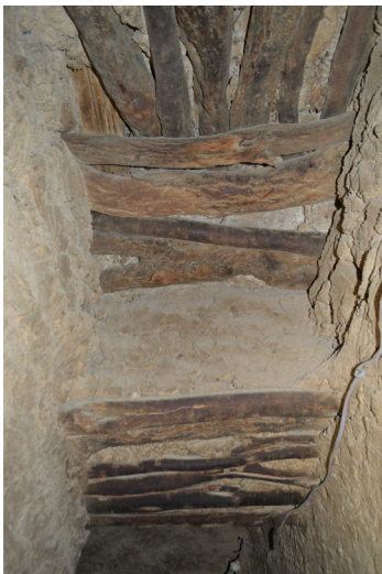
Fig. 18: Vue sur l'intérieur de la tour-minaret, détail sur l'assemblage des poutres de bois.
